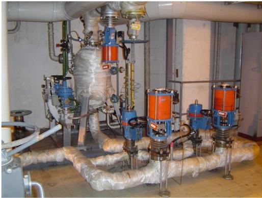
电控气操作，高参数，高精度，有减压、减温、液位三回路控制，有喷水故障保护。控制精度±1.5%
